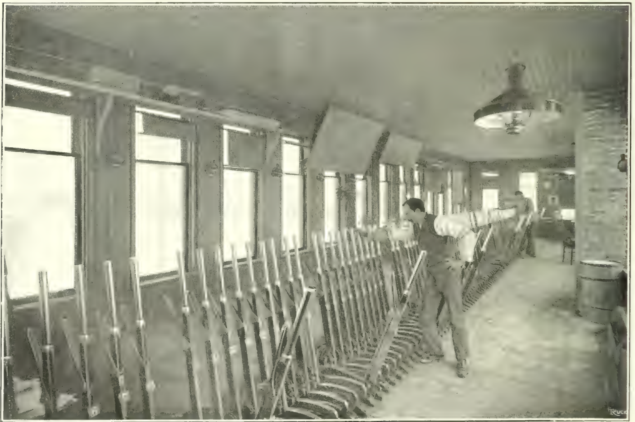
UNE SALLE D'AIGUILLAGE. — Sur les voies américaines, la trame des rails est si enchevêtrée à certaines bifurcations importantes qu'elle exige tout un système d'aiguillage perfectionné.
